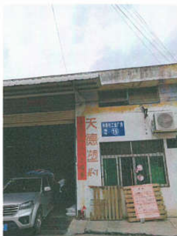
主体工程建筑
