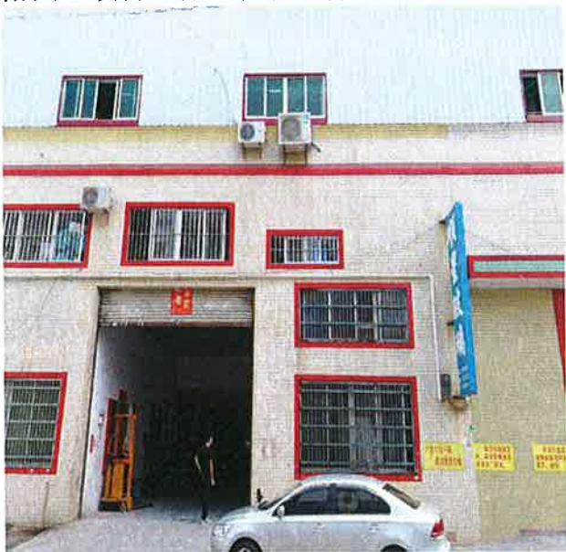
主体工程建筑
