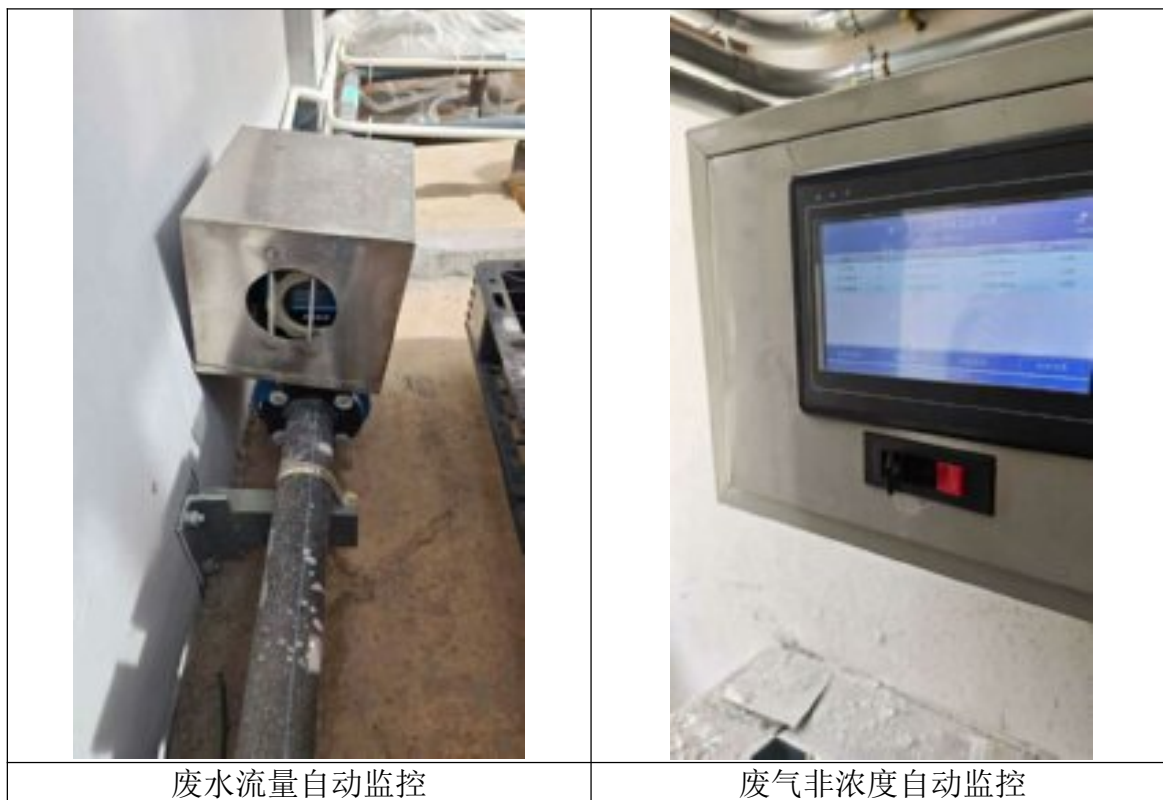
图 4.2-4 废水流量自动监控及废气非浓度自动监控装置
