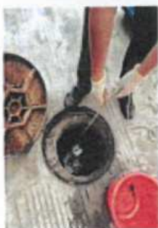
生活污水 排放口★1#
