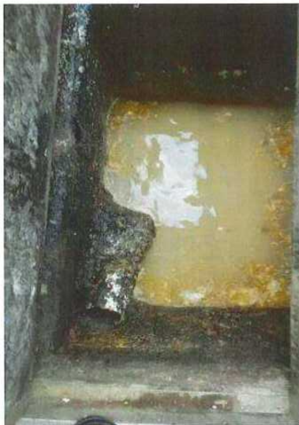
图 3 隔油隔渣池
